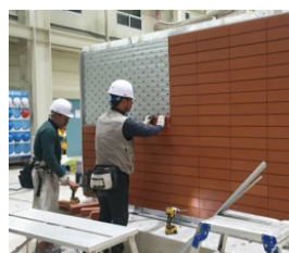
T-brick 외장 설치
