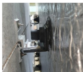
석재 OPEN JOINT 공법
